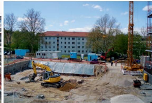
**April 2016:** Die letzten Bohrpfähle sind verbaut, einige werden „abgespitzt“. Die Baugrube wird anschließend vertieft.
