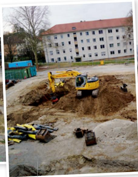
**März 2016:** Die Bagger werden größer: Alte Leitungen werden aus dem Baugrund ausgegraben.
