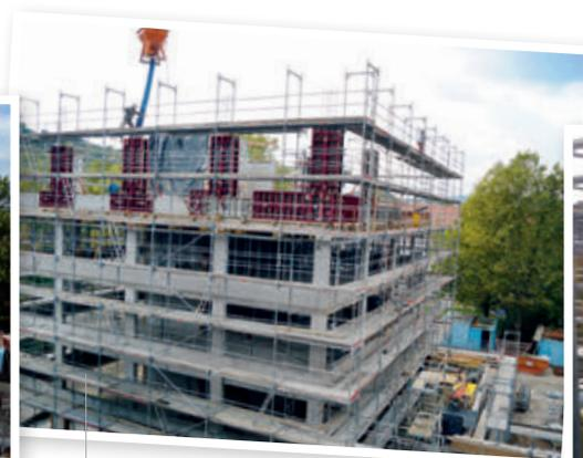
**November 2016:** Der Rohbau ist weitgehend fertig. Es geht weiter mit der Dachabdichtung, der Dämmung und dem Einbau der Fenster.
