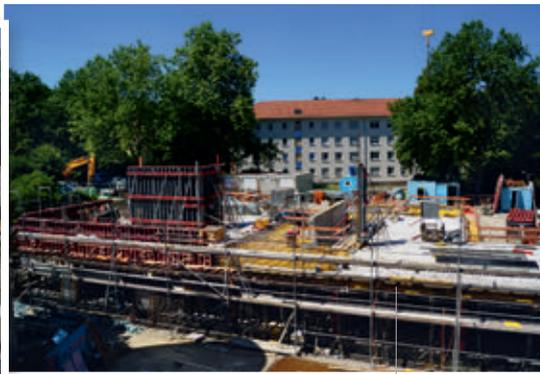
**August 2016:** Die Bauarbeiten am ersten Geschoss haben begonnen, bevor die Decke über dem Erdgeschoss fertig ist.
