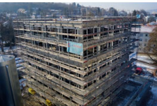
**Januar 2017:** Nach einer kurzen Weihnachtspause geht es weiter mit der Installation der Glaseinsätze für die Fenster und der Dämmung mit Mineralfaserplatten.
