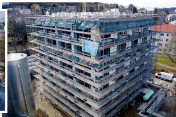
**Februar 2017:** Die Fenster sind eingebaut, die Dämmung ist fixiert und der Innenausbau hat begonnen.
