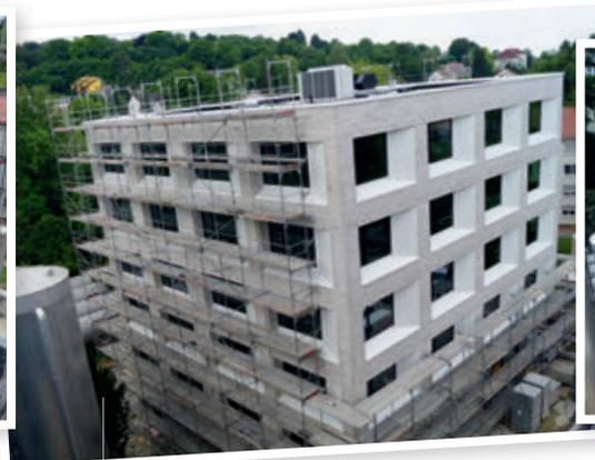
**Juni 2017:** Die Arbeiten an der Fassade sind fast fertig und auf dem Dach eine PV-Anlage mit 21,8 kW peak installiert.
