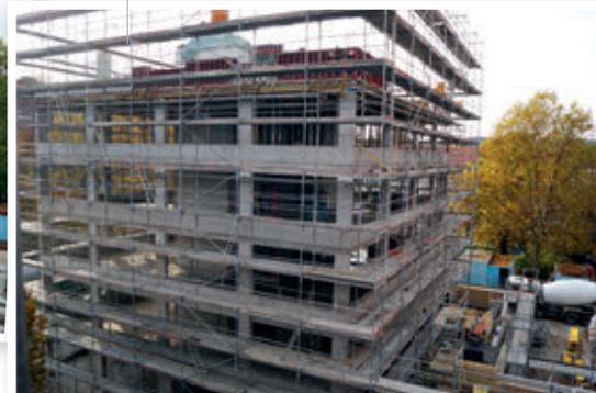
**Oktober 2016:** Die Arbeiten am sechsten Geschoss haben begonnen. Im Erdgeschoss ist der Einbau der Lüftungsanlage abgeschlossen.
