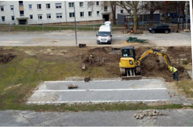
**März 2016:** Das Baufeld wird vorbereitet: Bäume und Sträucher sind gefällt; Baumwurzeln werden mit dem Bagger ausgegraben.
